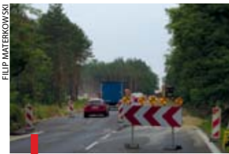
Dobiegają końca prace przy drodze wojewódzkiej relacji Tarnobrzeg–Stalowa Wola
