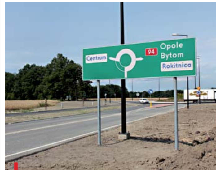
Przy okazji budowy drogi powstało nowe rondo
