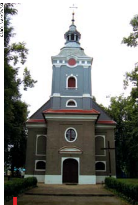
Gdyby nie zaangażowanie mieszkańców Kamiennej, budynek popadłby w ruinę
