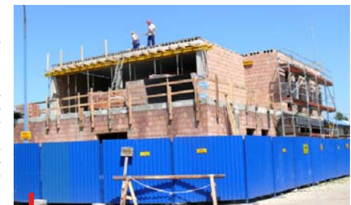
Trwają intensywne prace przy rozbudowie RIG
