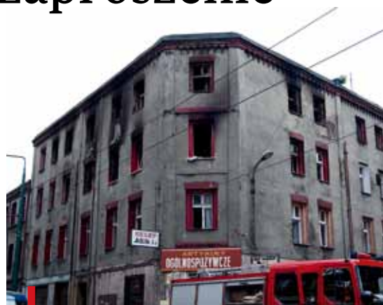
Trwają prace przygotowawcze umożliwiające ocenę stanu technicznego budynku oraz podjęcie śledztwa
