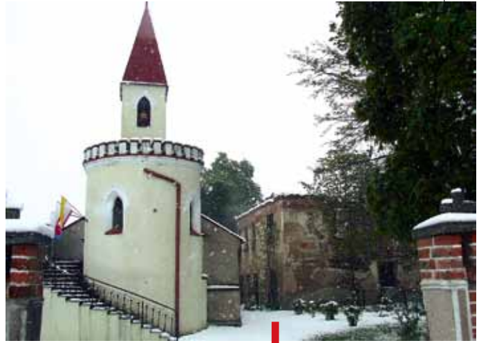
W latach 1981–1982 kaplica z czasów Moritza Brosiga była rozbudowywana
